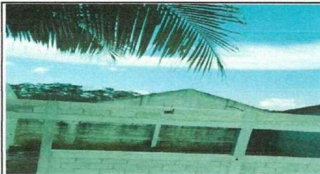
Foto 2: Colocacion de estructura de techo, pues el aula es recién construida.
