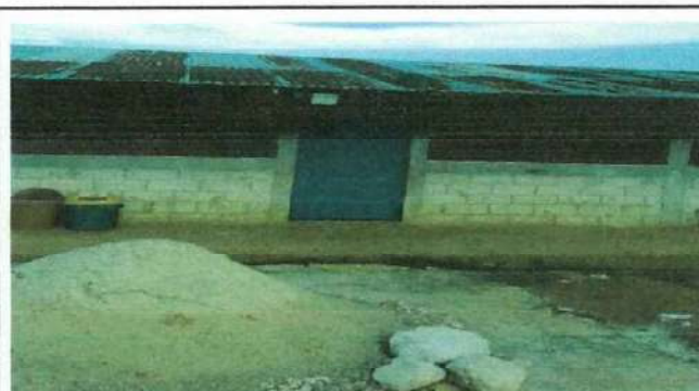
Foto 4: Cambio de cubierta de lamina pues las que posee estan deterioradas pues fueron instaladas hace mas de tres años.
