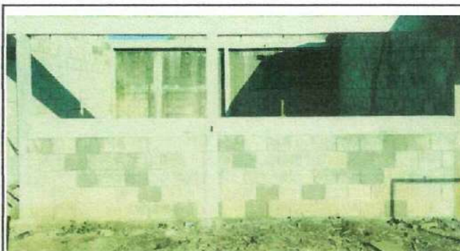
Foto 4: Colocacion de balcones de aulas recientemente construida.
