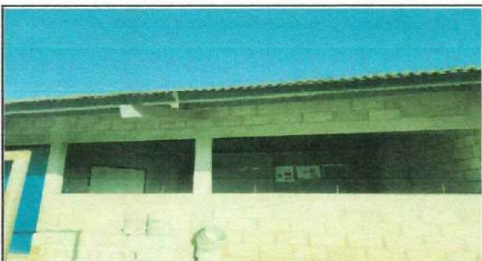
Foto 3: Colocacion de balcones porque los ventanales estan al aire libre.
